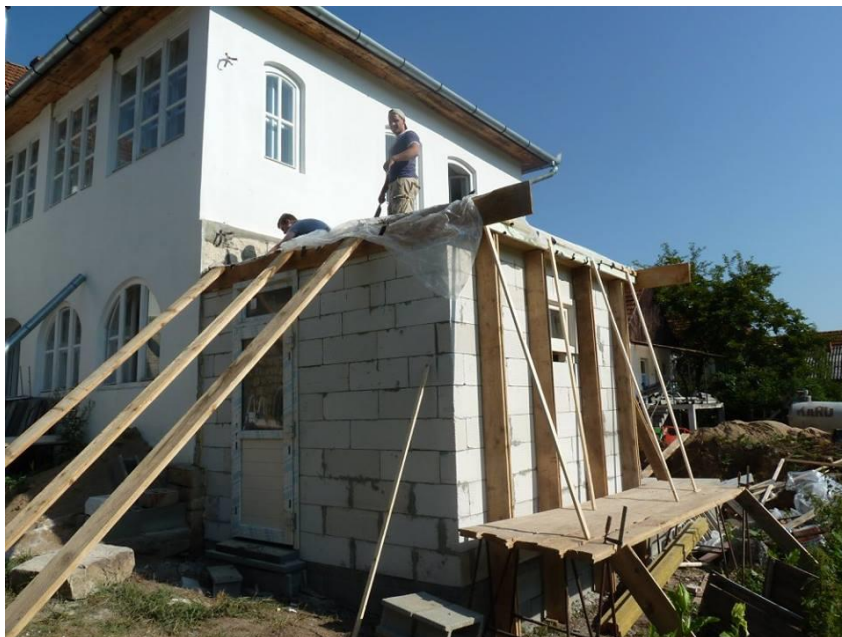
Een beeld van de werkzaamheden aan het Immanuelhuis
